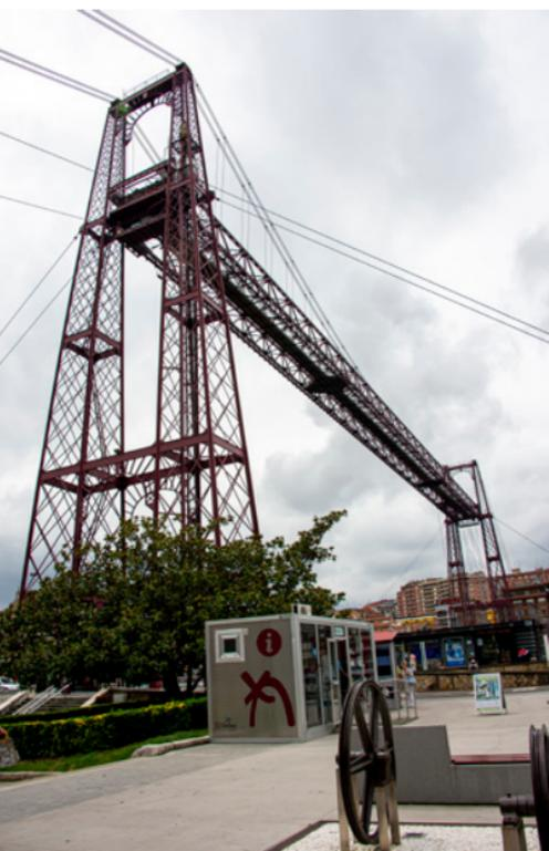
En 1999 se instalan ascensores en las torres de ambas márgenes y se habilita la pasarela en la viga superior, con objeto de introducir un uso turístico. Se construyó además una nueva barquilla y nuevos edificios de acceso, modificándose el carro de desplazamiento.
